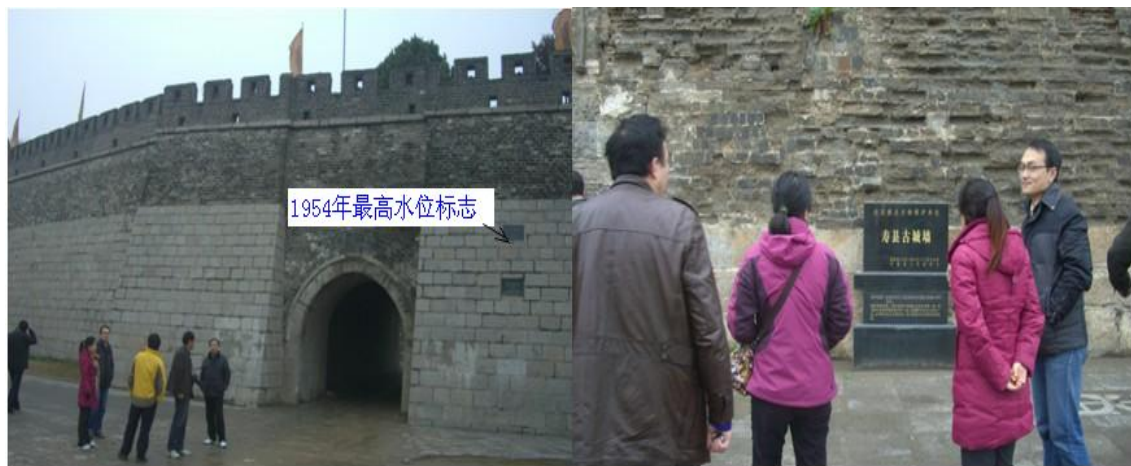
寿县古城墙（工程维护方案探讨）
